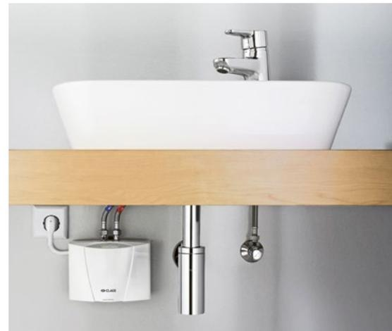
Wenn es darum geht, kleine, abseits liegende Zapfstellen energiesparend und mit geringem Aufwand mit Warmwasser zu versorgen, dann sind elektrische Durchlauferhitzer oft die erste Wahl.
